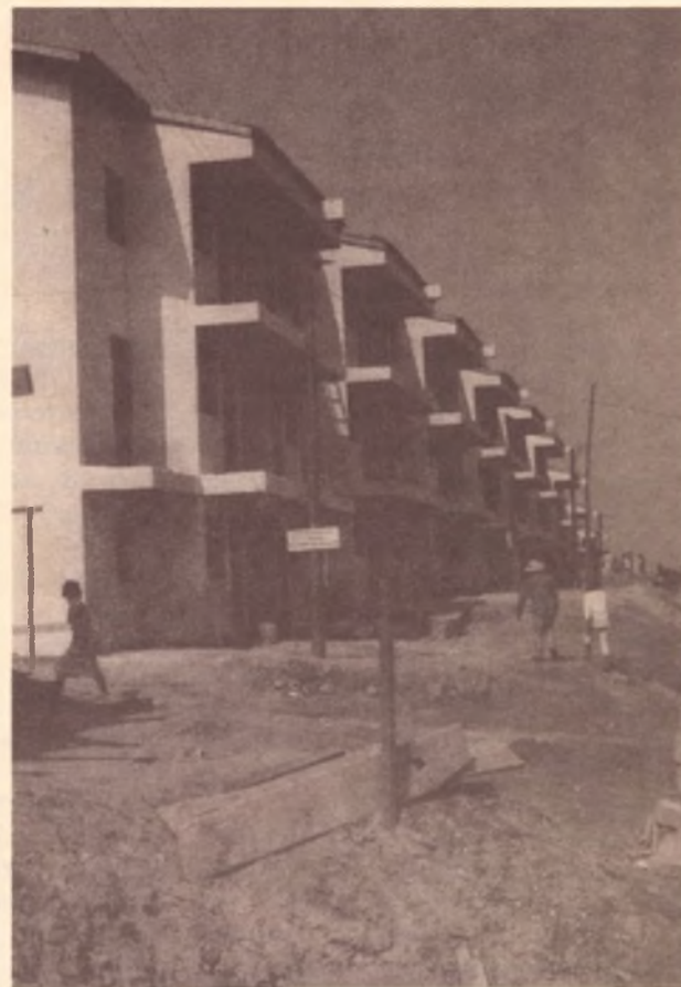
Construção de casas em mutirão, em SP
