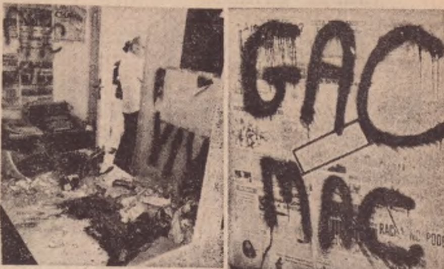
Danos provocados pelo atentado anterior (à bomba) contra a sucursal de Belo Horizonte.
